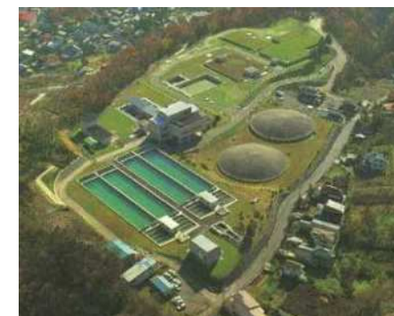
夏目ヶ原浄水場
