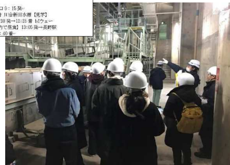
東部浄化センターの見学
