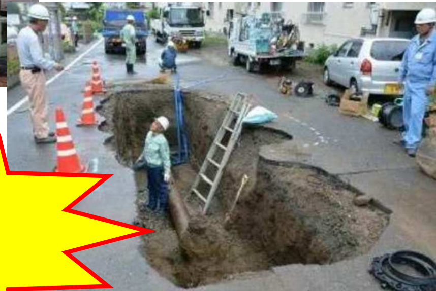
↓ 漏水による陥没事故（大分市）
