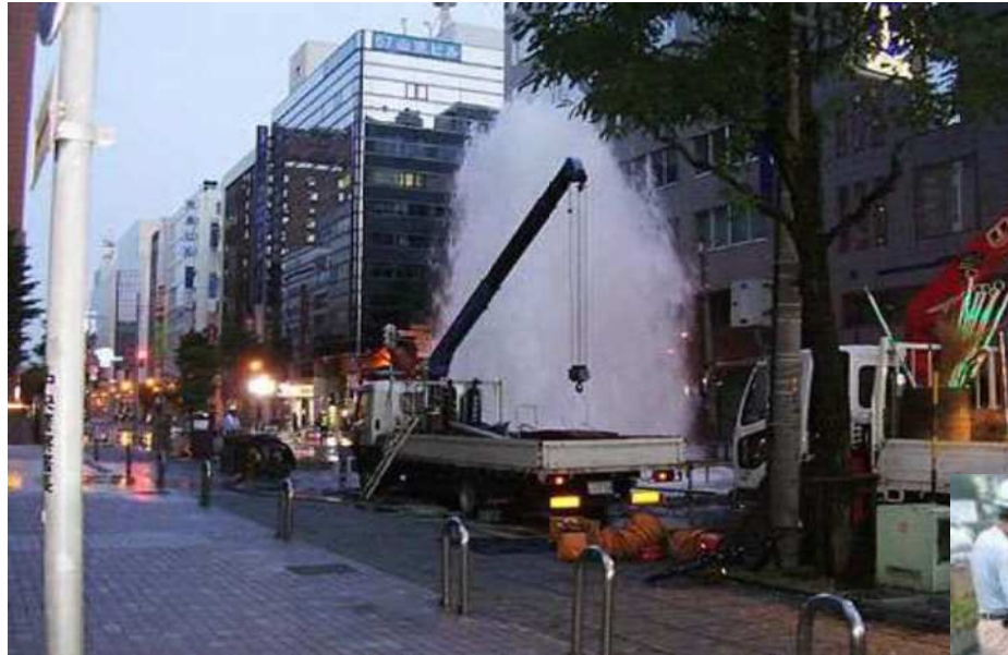
↑ 街中での漏水事故（札幌市）
