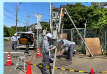
マンホールポンプ異物除去作業
