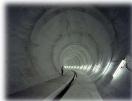
浸水から街を守る 雨水幹線
