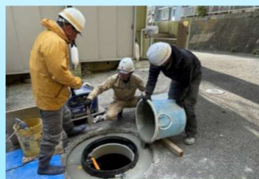
円形カッター工法施工
