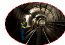
地盤改良 構造物メンテ事業
