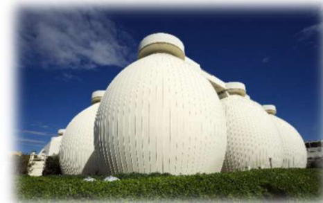
エネルギーを生み出す 消化タンク
