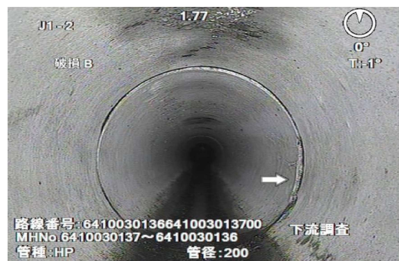
④ 管路調査
