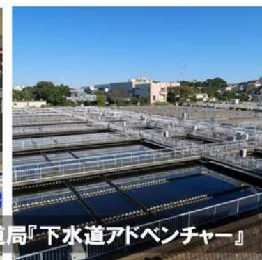
第二沈殿槽
