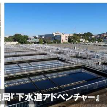
第二沈殿槽
