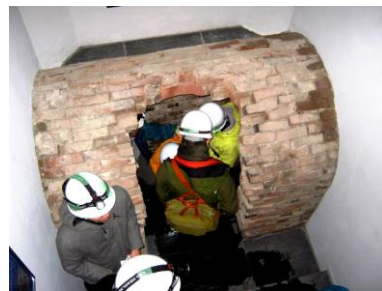
下水道管開口部↑
