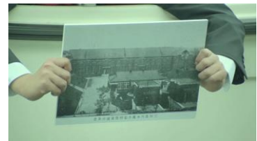
旧三河島污水処分場ポンプ場設備
