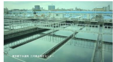
現在の三河島水再生センター
