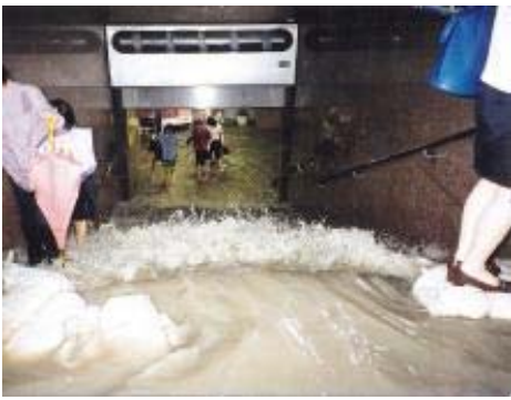
平成11年6月29日 博多駅地下街入口
