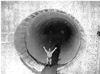
約3万トンの雨水がためられる貯留管(福岡市道路下水道局提供)
