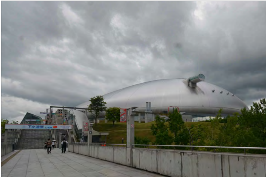
下水道展'23会場 札幌ドーム
