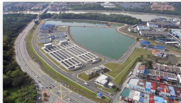
○マレーシア国スンガラニオルSTP (Sungranioru STP, Malaysia)
