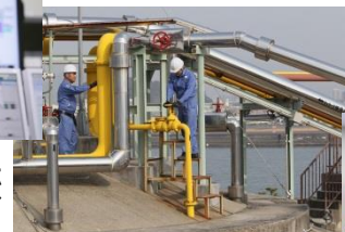
現場ではオペレーターが交代で24時間運転業務を行っています。
