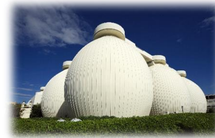
エネルギーを生み出す 消化タンク
