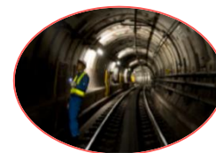
地盤改良 構造物メンテ事業
