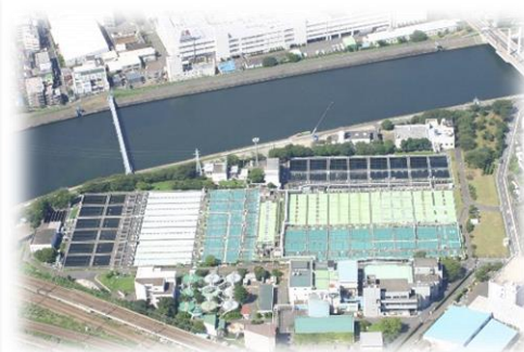
集まった下水をきれいにする 水再生センター
