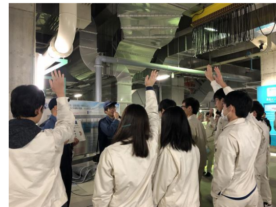
▲入江崎水処理センター
