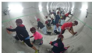
小学生を対象とした下水道施設見学会（工事中の管内に夢や思いを描いた）
