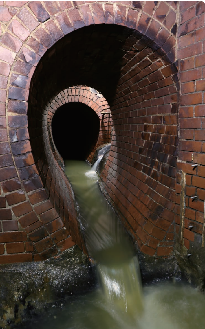
東京の近代下水道の先駆けとして知られる神田下水。明治時代にコレラなどの伝染病を予防する衛生改善の一環としてつくられた。レンガ積み卵形管(らんけいかん)は現役提供:東京都下水道局
