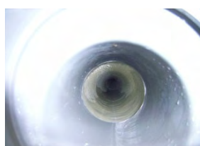
写真3 改善後の取付管
