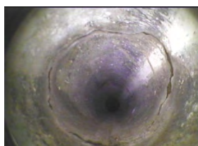
写真2 直す前の取付管
