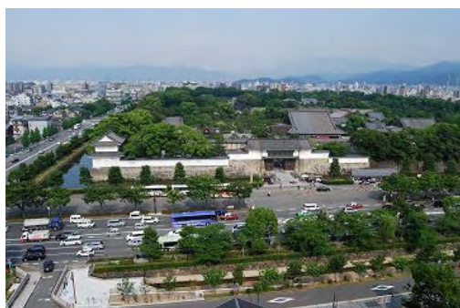
写真奥から世界遺産「二条城」「堀川通」「堀川」。車がたくさん通る堀川通の地下に巨大な下水道管が！
