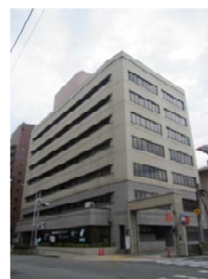
京都駅南口にある上下水道局の庁舎。交通の便が良いことが自慢です！
