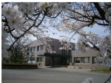
石井水処理センター管理棟
