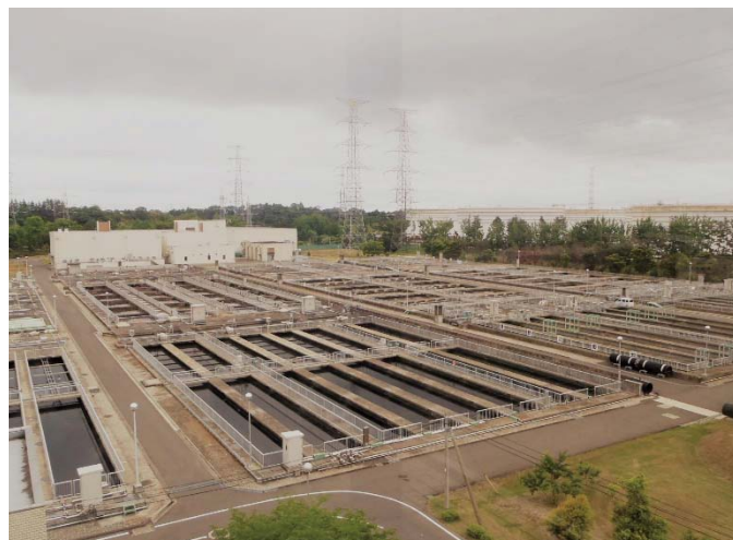
▲仙塩浄化センター 5階の展望室から処理場のしくみを見ることができます。
