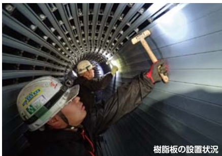
樹脂板の設置状況
