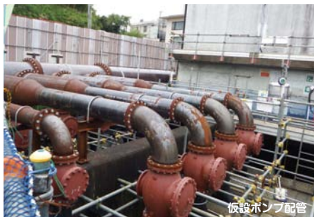
仮設ポンプ配管
