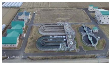
涌谷浄化センター
