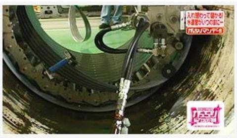
こちらがそのロボット！<br>ロボットが管になるプラスチックを、グルグルとパイプに合わせて這わせていきます。 |  |
