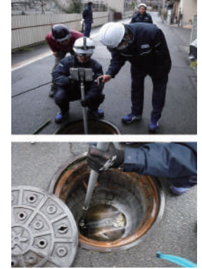
地上からの調査点検の様子
