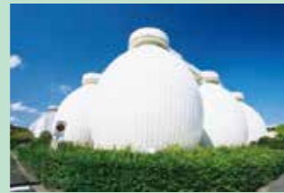
バイオガスを生成する 横浜市北部汚泥資源化センター
