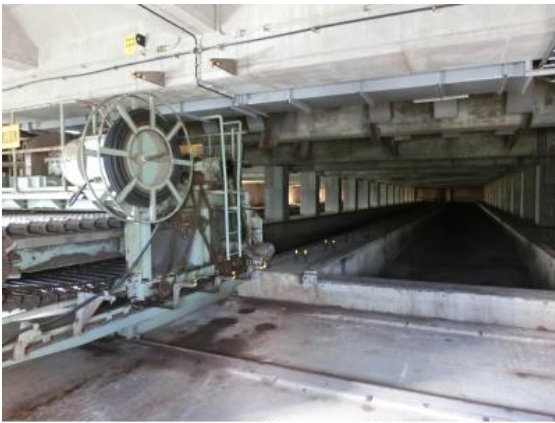
二次発酵槽と切返し機
